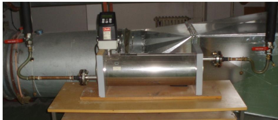
Sl. 4.14. Ugrađeni uređaj za mjerjenje masenog protoka ogrjevnog medija *MASSFLO*
