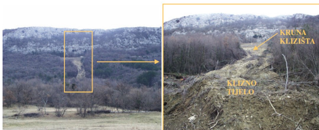
Slika 4.5 Tok sitnozrnastog materijala tla Krbavčiči reaktiviran u siječnju 2003. godine (foto: Ž. Arbanas, 2003.)
