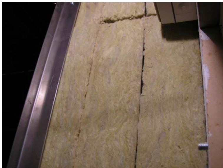
Slika 4.4. Slojevi kamene vune u gluhoj komori
