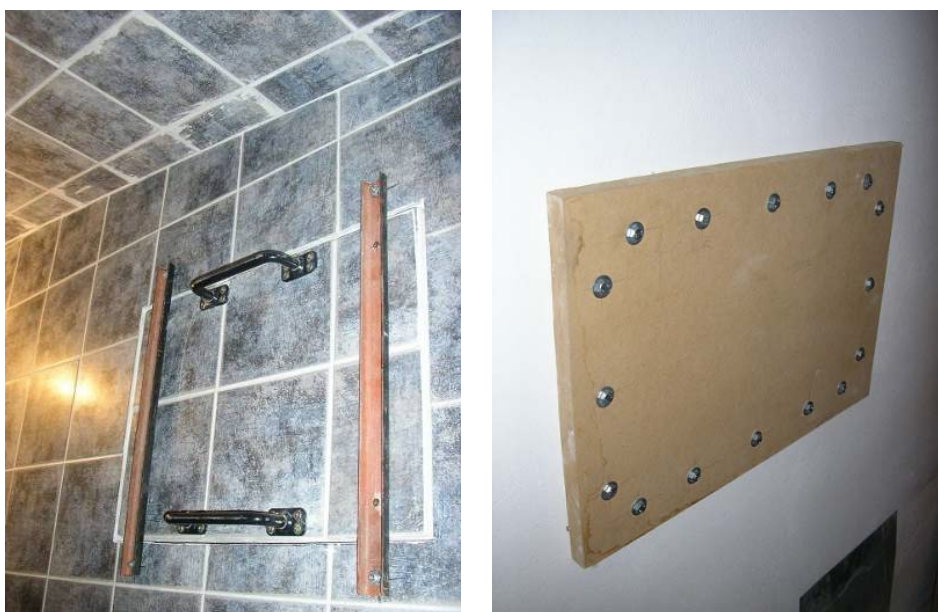
Slika 4.5. Izgled zatvorenog prozora (lijevo: pogled sa strane ječne komore, desno: pogled sa strane gluhe komore)
