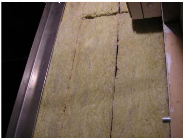
Slika 4.4. Slojevi kamene vune u gluhoj komori
