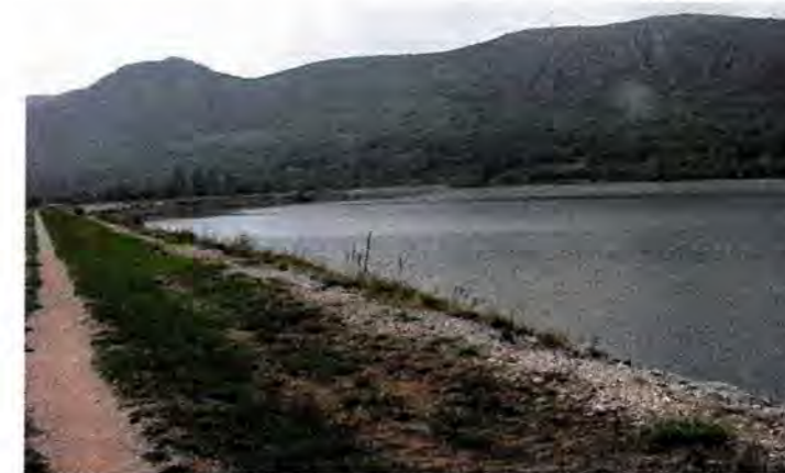
Slika 5.3. Akumulacija Tribalj (pogled s brane)
