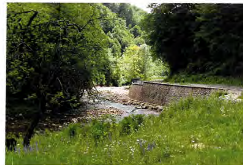
Slika 5.24. Obaloutvrde u funkciji zaštite prometnice uz rijeku Čabranku
