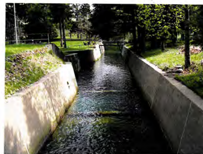
Slika 5.46. Odvodni/dovodni kanal u krugu CHE Fužine, pogled od izvora Ličanke nizvodno
