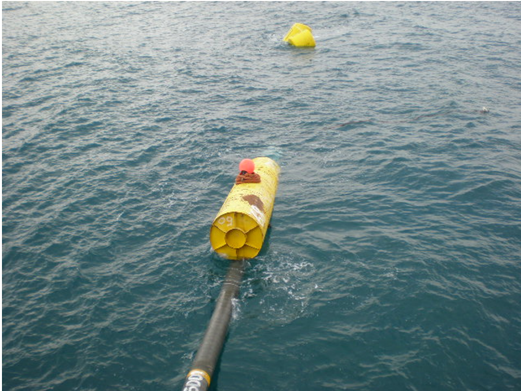
Slika 2.13: Upotreba uzgonskih spremnika prilikom polaganja
