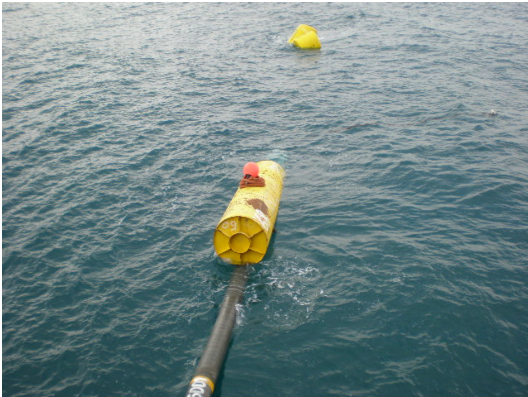
Slika 2.13: Upotreba uzgonskih spremnika prilikom polaganja
