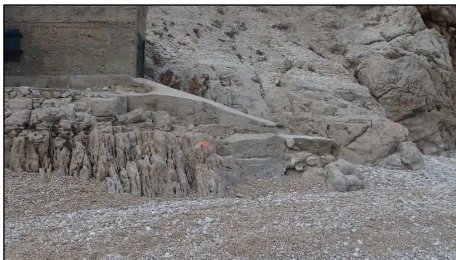
Slika 5.11. Kontrolne točke - fiksne oznake na stijenama 18 i 19 (slika 5.7.), snimljeno 18.11.2013.
