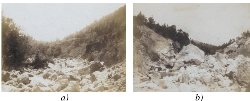
Slika 3.15. a) Vodotok Rječina nakon klizanja 1885., stacionaža 10+60 km (Državni arhiv grada Rijeke – kutije A; B; C), b) klizište iz 1893. godine na lijevoj obali Rječine nasuprot naselja Grohovo (Državni arhiv Rijeka – kutija B)
