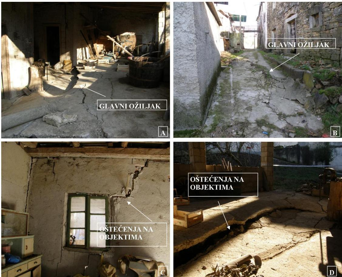
Slika 4.16 Fotografije snimljene nakon početka klizanja na klizištu Juradi: a) i b) fotografije glavnog ožiljka; c) i d) fotografije oštećenja na objektima unutar klizišta (travanj 2011.)
