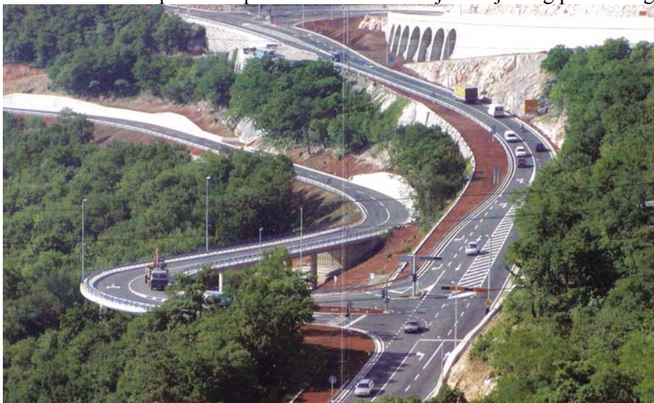
Slika 9. Cestovni prometni pravac na istočnom dijelu Riječkog prometnog čvora
