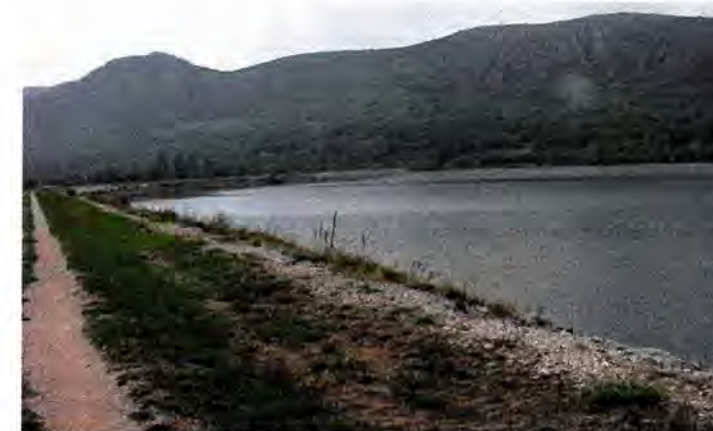
Slika 5.3. Akumulacija Tribalj (pogled s brane)
