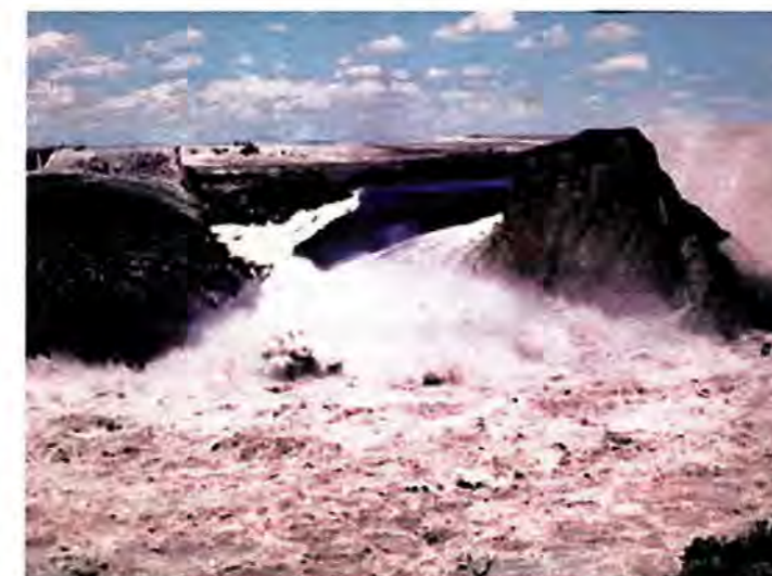
Slika 5.1. Nekontrolirano istjecanje vode kroz propust u brani Teton
