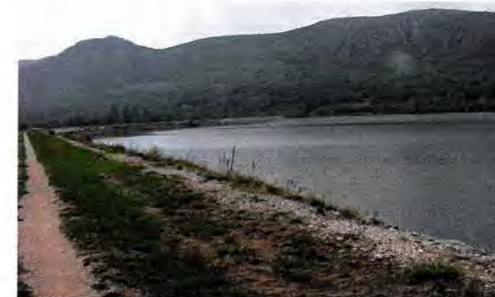
Slika 5.3. Akumulacija Tribalj (pogled s brane)
