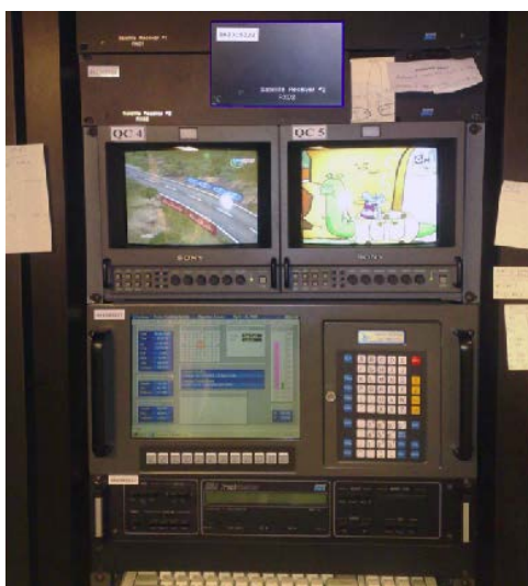
Slika 52: Kontrolni uređaj za kontrolu i pozicioniranje SAT antene
