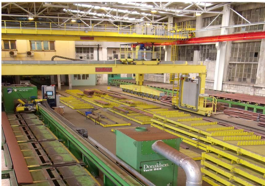
Slika P5.1 Prikaz dijela linije na kojoj se vidi robotska stanica za rezanje profila, palete za sortiranje i sortirna dizalica
